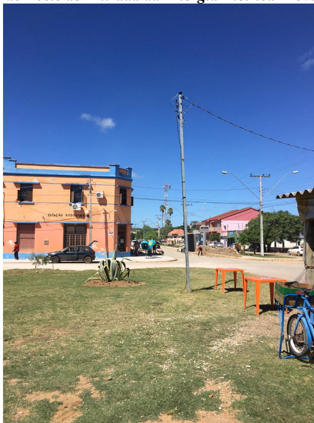
Foto do Poste de Entrada da Energia Elétrica Provisória
