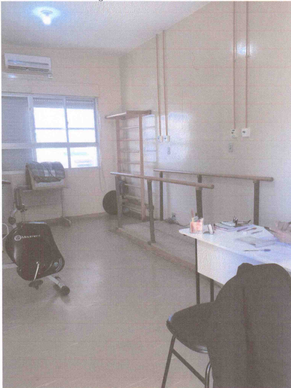
Imagem do Piso a ser Removido
