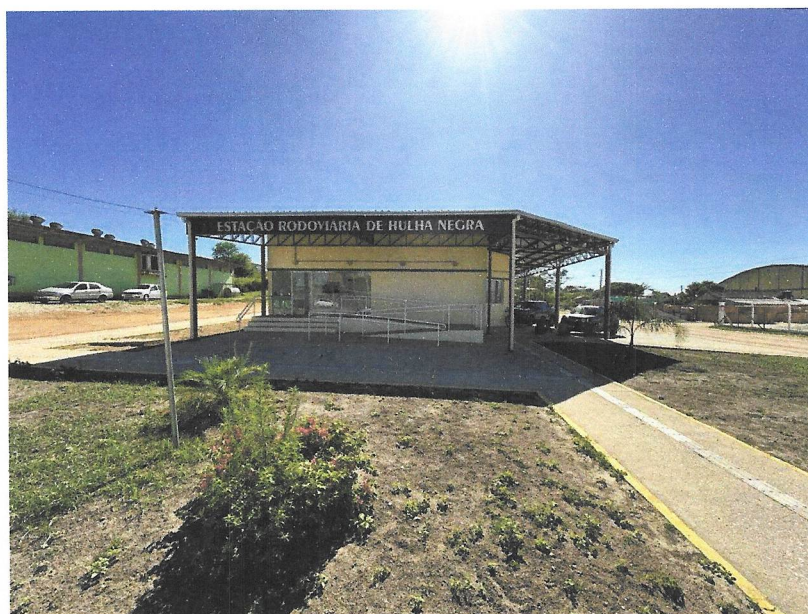
Fachada pela Av. Getúlio Vargas
